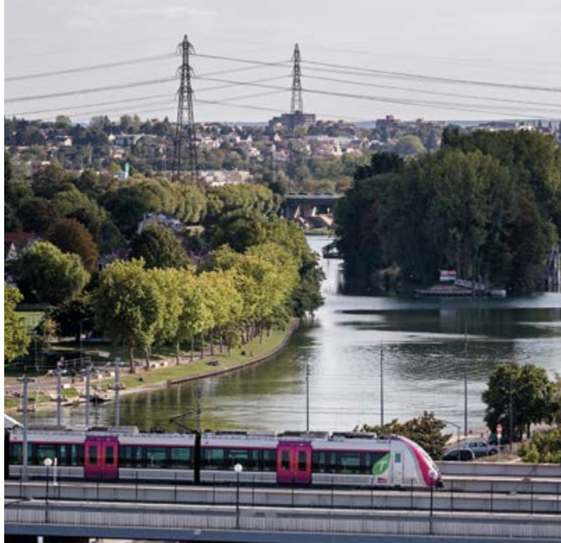
瓦兹河上的铁路桥 © 皮埃尔·伊夫·布鲁诺 (Pierre-Yves Brunaud) - 巴黎大区研究院
